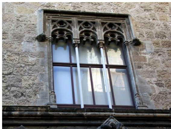
Trifora sul prospetto di Alloro
