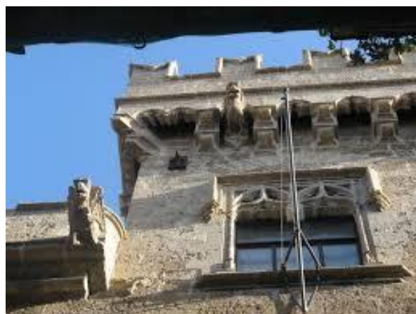
Particolare torre merlata
